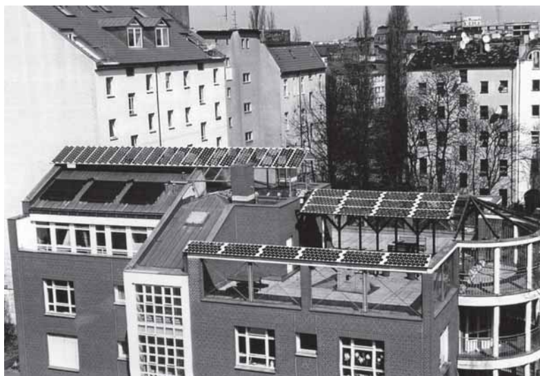
Photovoltaikanlage auf dem Dach der Kita in der Cuvrystr. 36
