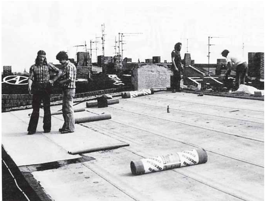
650 qm Dach werden von den Bewohnern des Kerngehäuses neu gedeckt.
