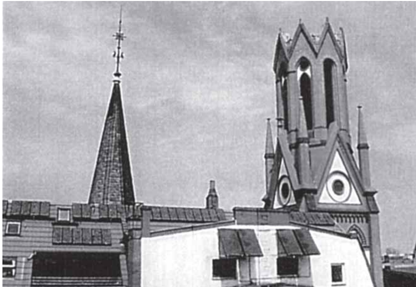
Die Solaranlage auf dem Dach der Taborkirche
