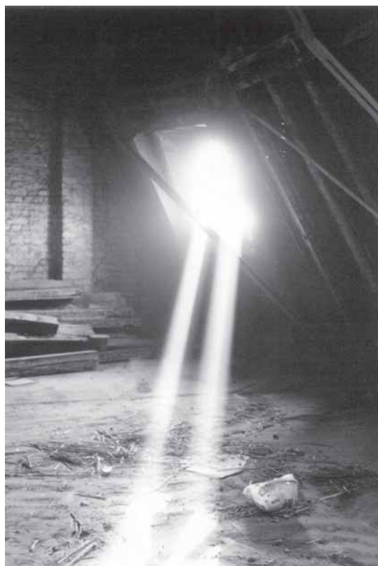
Dachgeschoss vor dem Ausbau
